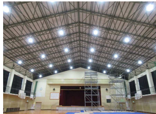
中学校体育館へのLED照明導入
