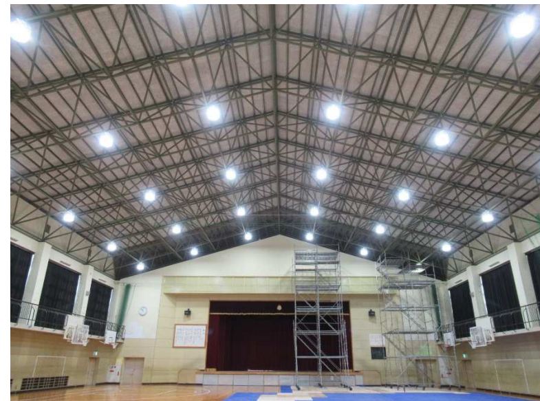
中学校体育館へのLED照明導入
