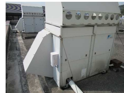
空調用省エネ制御装置の設置
